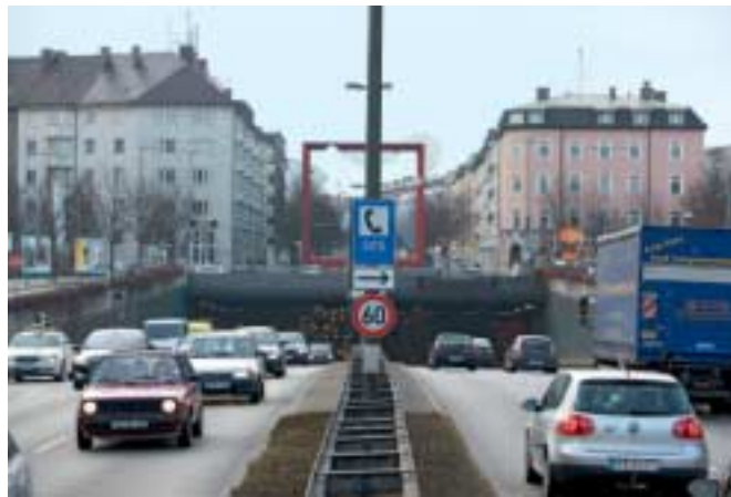
3 Portal des Brudermühltunnels in München mit täglich 109000 Fahrzeugen
