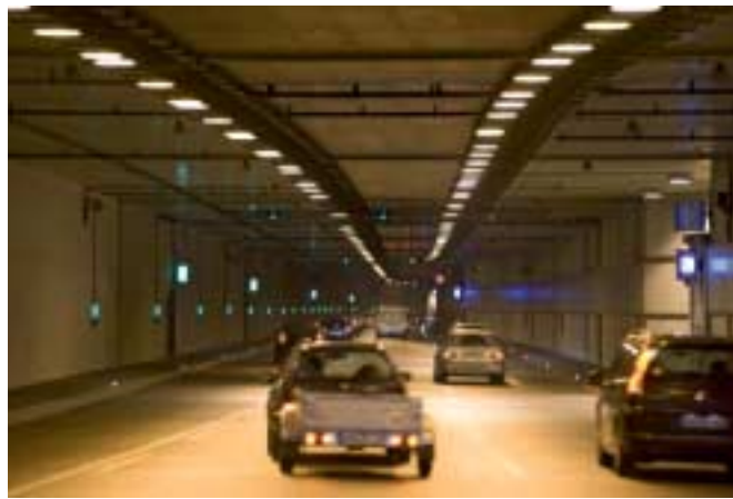
1 Stadt-/Autobahntunnel unter den Start- und Landebahnen des Flughafens Tegel – Blick in eine der beiden Röhren
