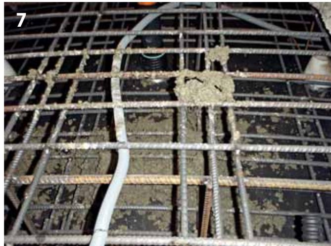
In der Tübbingbewehrung verlegter Verpressschlauch während der Betonage
