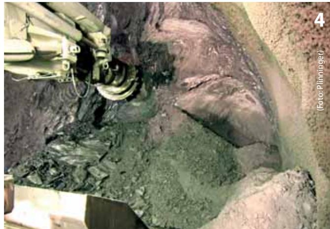
Ausbruch mit der TSM in Quarzphylliten. Durch die geringe Zerlegung des Gebirges sind die Schneidspuren jedes Meißels an der Ortsbrust deutlich erkennbar
