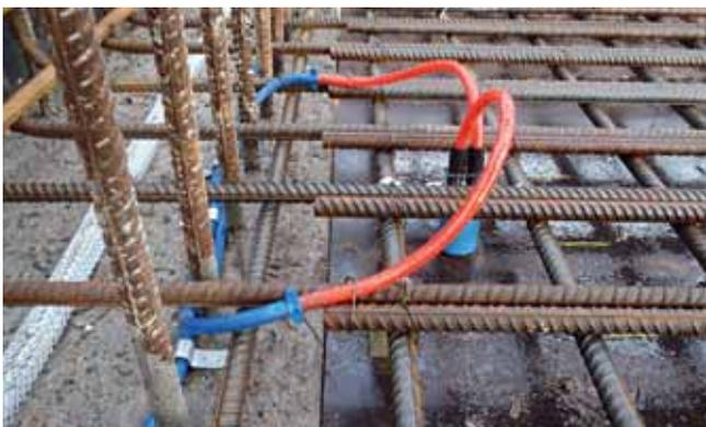
HauCon lieferte bereits über 3.000 m Injektionsschlauch WaterproofX® 100 von StekoX® auf die Baustelle
