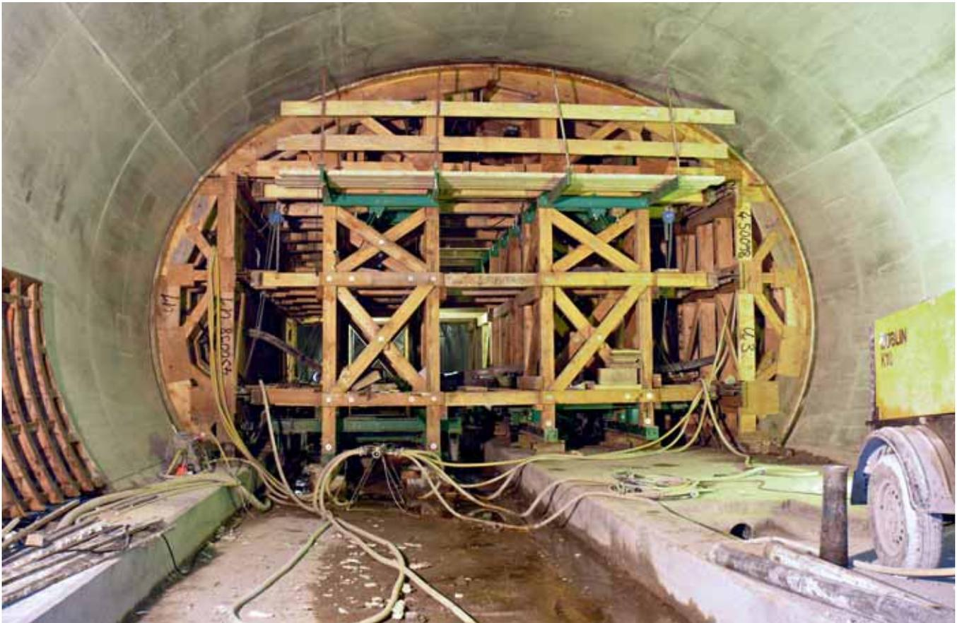
Der verfahrbare Schalwagen ermöglichte eine termingerechte Fertigstellung. Auch nach 20 Einsätzen zeigt die alkus Vorsatzschalung GM 6 fast keine Verschleißerscheinungen
