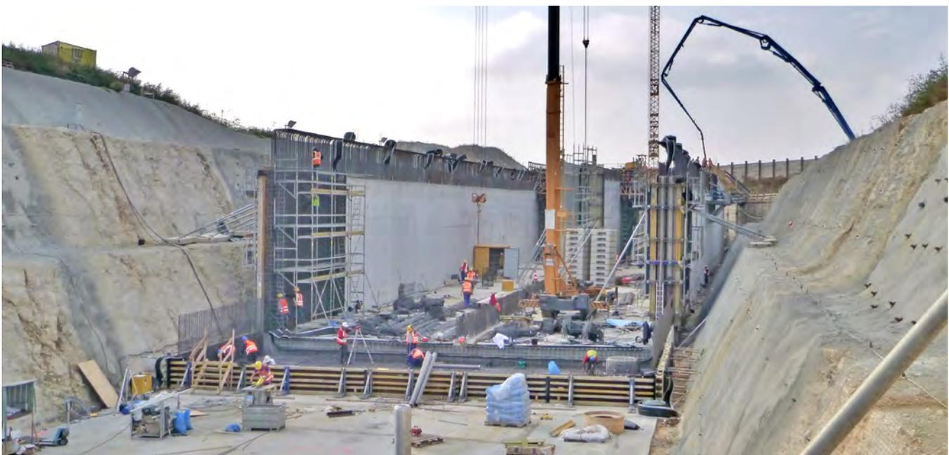
**7** Betonierarbeiten an Sohle, Wänden und Deckel (28.9.2016)
