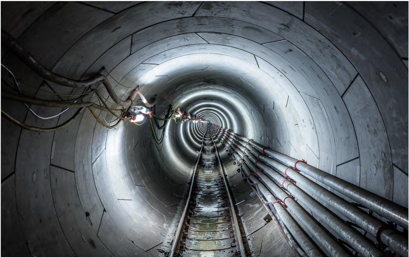
Im Gegensatz zu den vorangegangenen Bauabschnitten des Abwasserkanals Emscher wurde der Bauabschnitt (BA) 40 nicht im klassischen Rohrvortrieb aufgeföhren, sondern aus Tübbingen erstellt
