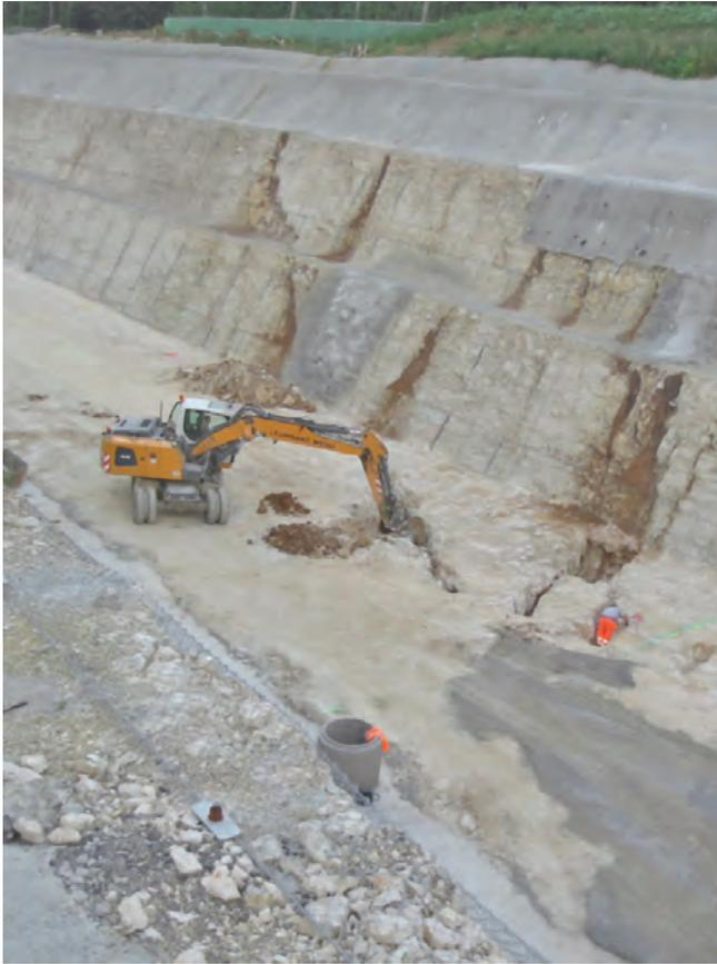
**10** Ausräumen lehmgefüllter Spalten und Sanierung durch Betonfüllung
